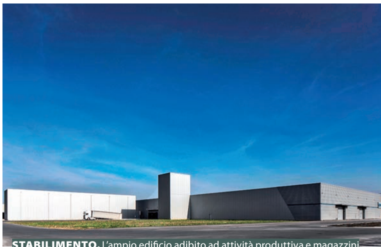
STABILIMENTO. L'ampio edificio adibito ad attività produttiva e magazzini è rivestito esternamente con pannelli di lamiera grecata microforata
