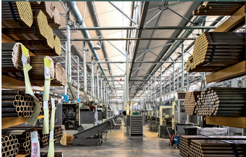
IN FABBRICA. Reparti produttivi e magazzini della nuova sede di Rubinetterie Bresciane. Lo stabilimento si caratterizza per il buon isolamento dell'involucro, impianti con recupero di calore e illuminazione naturale garantita dagli shed in copertura, che nel lato obliquo esposto a sud ospitano pannelli fotovoltaici.
