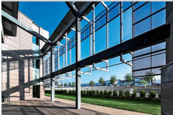
INVOLUCRO. Parete ventilata in fibrocemento e schermatura in lamiera stirata caratterizzano l'involucro della palazzina uffici annessa alla fabbrica
