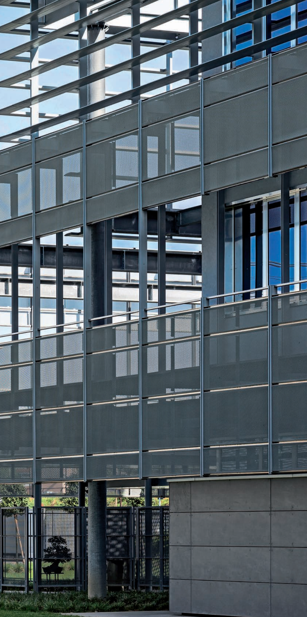
Parete ventilata e rivestimento in lamiera stirata nella palazzina uffici
