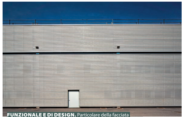
FUNZIONALE E DI DESIGN. Particolare della facciata dell'opificio, realizzata con pannelli sandwich ad alto isolamento termico rivestiti esternamente con lamiera grecata microforata
