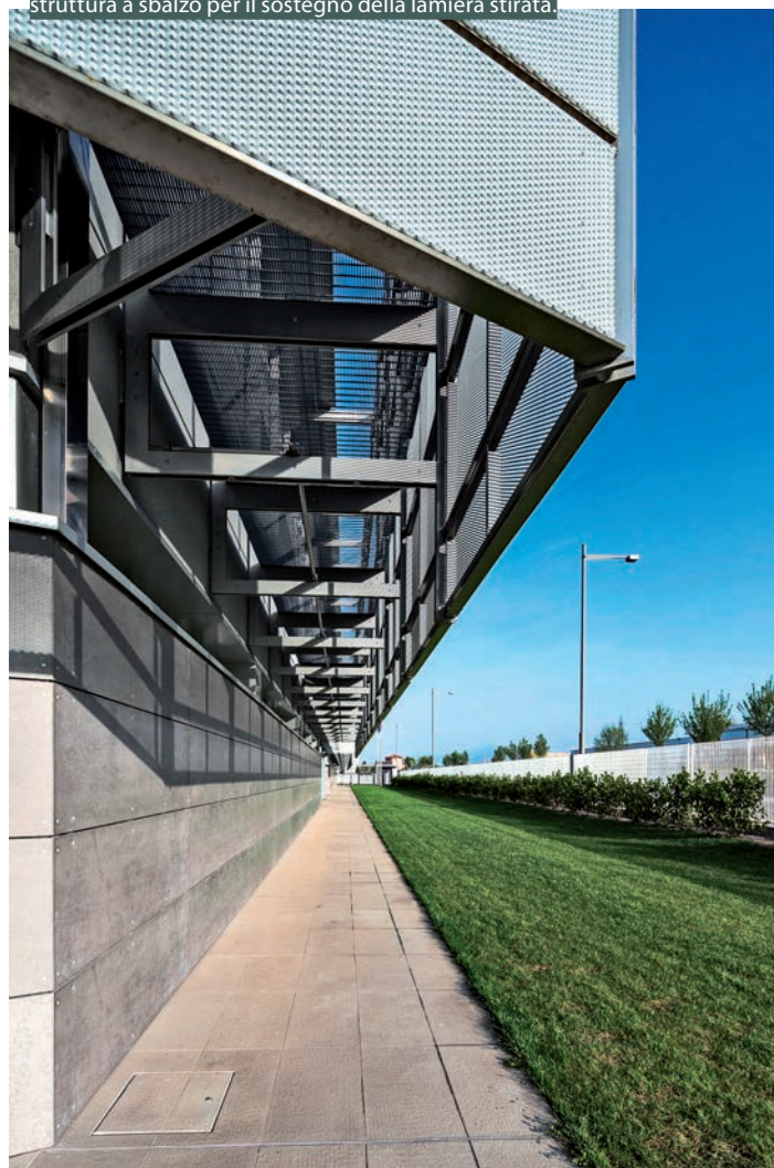
FACCIATA. Particolare del camminamento e della struttura a sbalzo per il sostegno della lamiera stirata.
